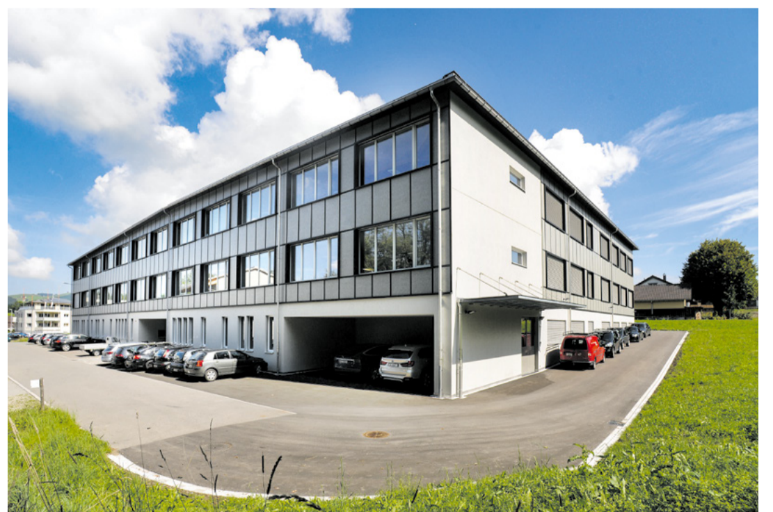
Im Bereich der weissen Wand an der Südseite des Wyon-Gebäudes soll mit einer doppelstöckigen Passerelle die Verbindung zum geplanten Neubau geschaffen werden. Dieser wird auf der unverbauten Wiese rechts der rechten Bildkante entstehen.
